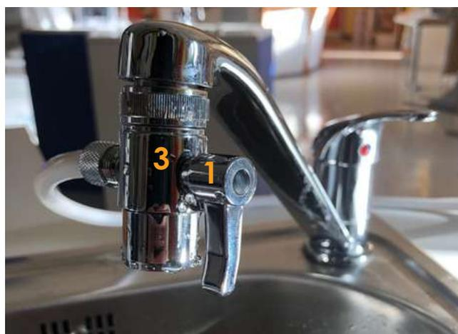
1. Rubinetto deviatore, in posizione verticale eroga l'acqua di rete, in posizione orizzontale l'acqua filtrata
